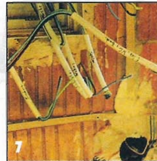
7 На каждый провод надевают изоляционную трубку с маркировкой.
