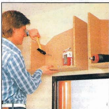
Короба-перемычки подвешивают на стене симметрично относительно дверной коробки, отступив вверх от перемычки проёма.
