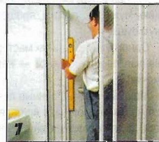
Чтобы двери душевой кабины легко открывались и закрывались, каркас ограждения кабинки тщательно выставляют по уровню.
