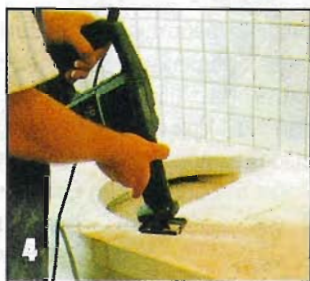
Электроножовкой (можно — лобзиком) вырезают проём для раковины умывальника.
