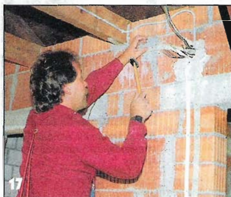
Кабели с защитной оболочкой крепят хомутами, плоские провода — гвоздями или клеем с помощью пистолета.
