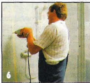
Чтобы сверло не уходило в сторону, в местах сверления крепёжных отверстий на облицовке из керамической плитки наклеивают изоляционную или малярную ленту.
