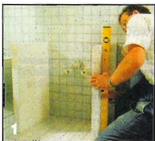
Из газобетонных блоков сооружают боковые стенки тумбы под умывальник.
