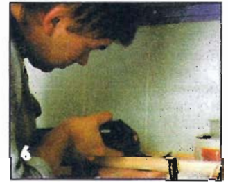
Полку без крышки привинчивают к стене.
