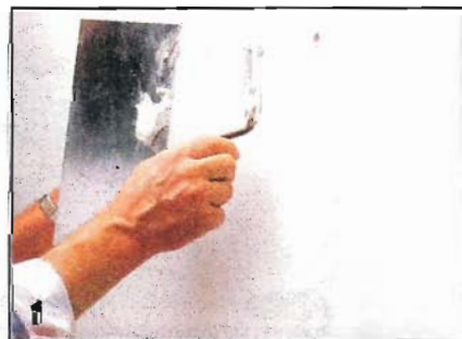
Сначала шпательюют трещины и неровности на стенах.
