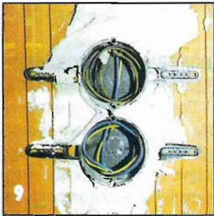
9 Введённые в розетку провода закрепляют гипсом.
