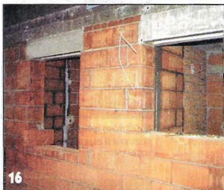
Наружное освещение требует собственных элементов подключения.
