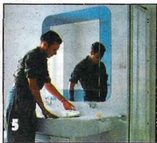
После облицовки шкафчика монтируют раковину.
