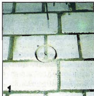
1 С помощью буровой коронки выбирают гнезда под выключатели и розетки.
