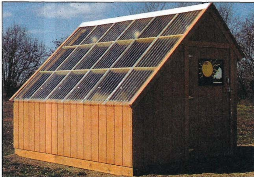
Панель из прозрачного сотового пластика смотрит на юг и наклонена под углом, равным широте местности.
