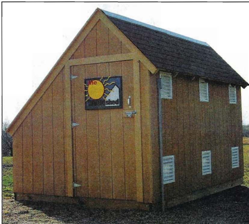
Проёмы для притока/выхода воздуха расположены на северной стороне сушилки. Доски легко внести и сложить в штабель через широкую утеплённую дверь.
