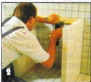
К стене на дюбелях и шурупах крепят деревянный опорный брусок для крышки тумбы из газобетонных блоков.
