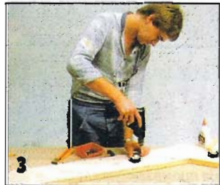
3 Просверлив в нижнем листе фанеры отверстия и протянув через них провода, подключают галогенные светильники и привинчивают их к промежуточным брускам.
