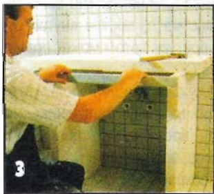
Еще одним деревянным бруском связывают боковые стенки тумбы спереди.
